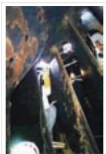
Figura 1 - Soldadores entre as pás de uma turbina hidráulica da Unidade Geradora de Salto Santiago – Tractebel Energia
