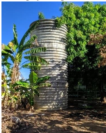
Imagem 5- Caixa d'água da escola.
