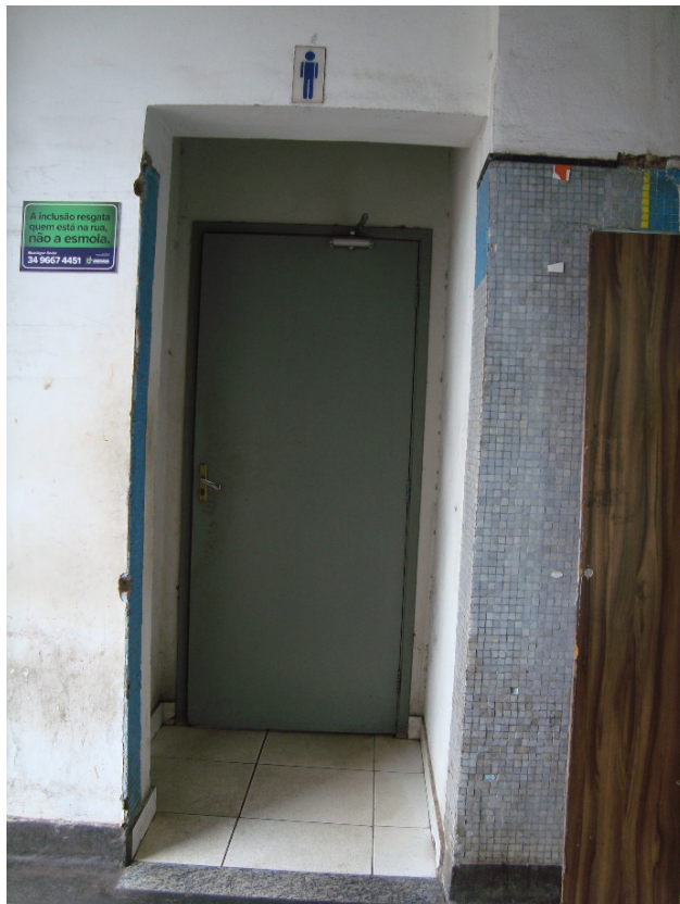
Figura 12 – Entrada do banheiro masculino
