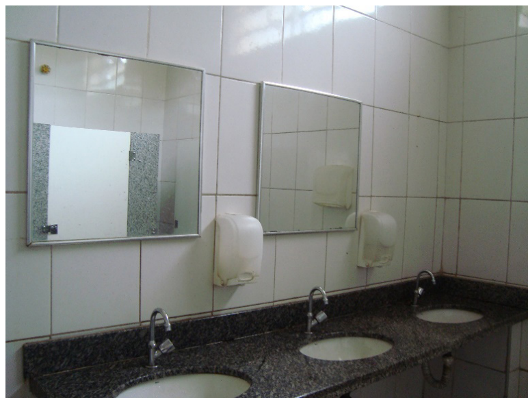
Figura 11 – Lavatório banheiro masculino
