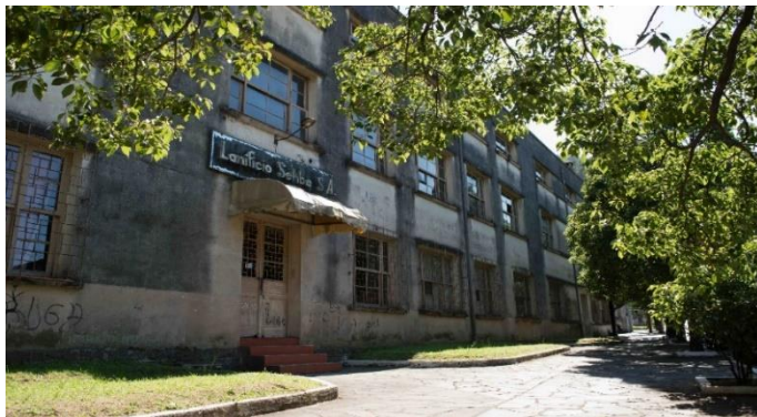
Foto: Fachada do Escritório do Lanificio São Pedro S. A. Galópolis, Fotógrafo: Leonardo Herédia, 2016.
