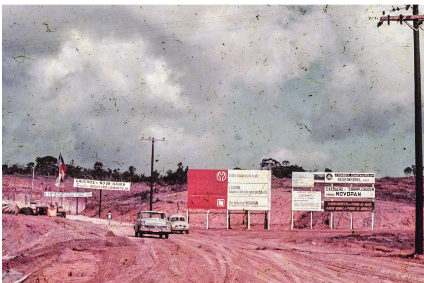
Simões Filho, BA – terraplenagem da entrada da futura fábrica NOVOPAN, no recém implantado Centro Industrial de Aratú. 1967, circa .
