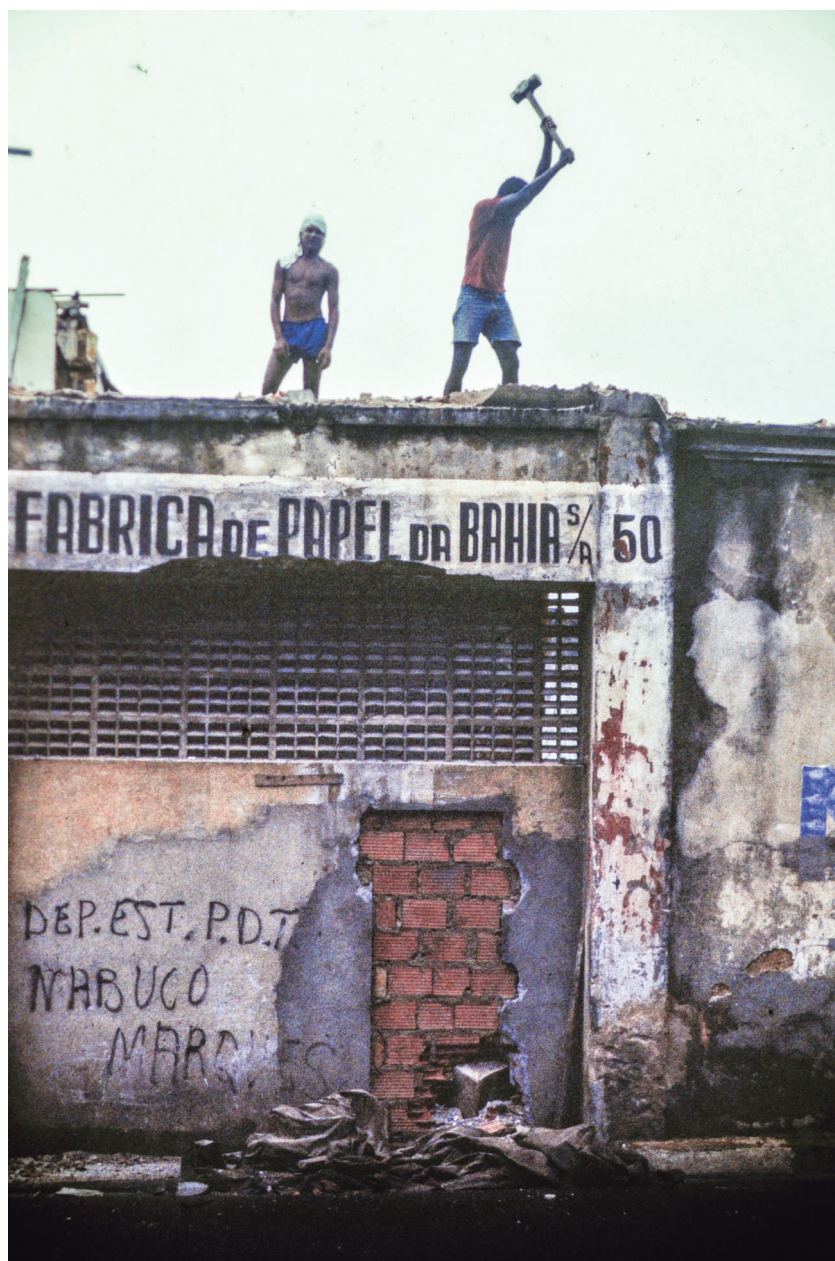
Salvador, BA – derrubada da fábrica de Papel e Papelão (Movimento da Fábrica). 1985.
