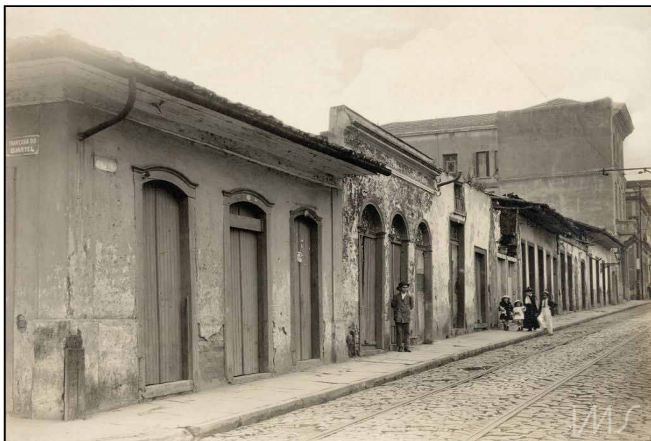
Imagem 6 – Fotografia de Vincenzo Pastore: Casario da Rua da Esperança, esquina com a Travessa do Quartel, zona do baixo meretrício, região da atual Praça da Sé. São Paulo (1910). Acervo: Instituto Moreira Salles. São Paulo - SP
