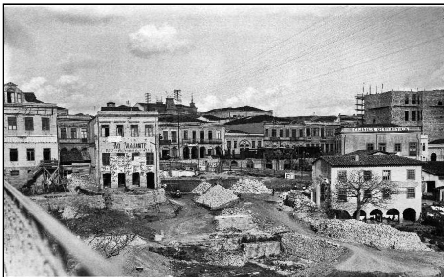
Imagem 7 – Fotografia de Aurélio Becherini dos trabalhos de demolição dos prédios desapropriados para o alargamento da Rua Líbero Badaró. São Paulo, 1912. Acervo: Instituto Moreira Salles. São Paulo – SP.
