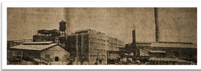
Figura 1: Prédio das câmaras frias - 1943
