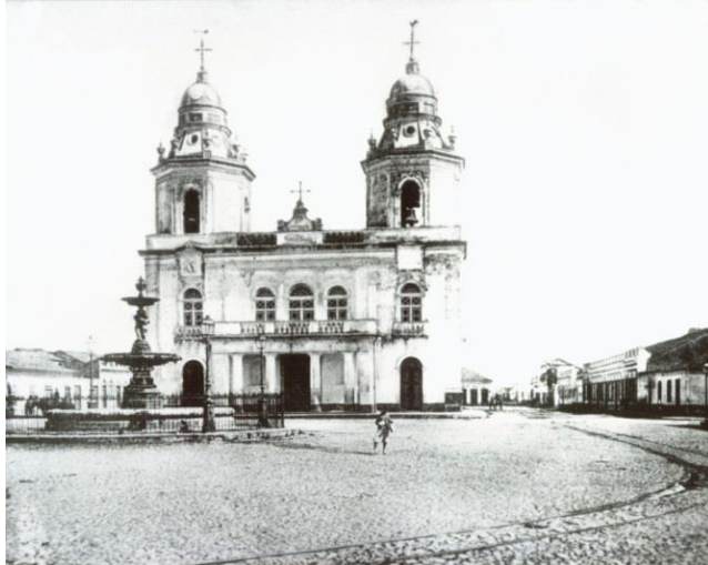
Imagem 1 – Chafariz da Matriz – 1902, instalado para o serviço de venda de água.
