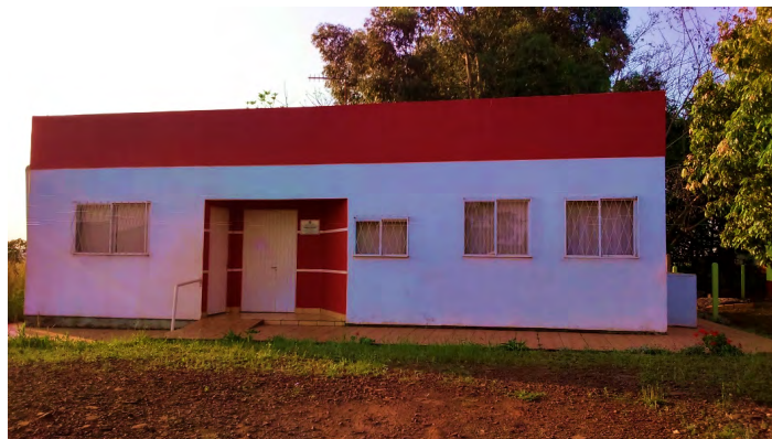
Figura 51 – Registro fotográfico da Unidade Básica de Saúde na Comunidade 16 de Março
