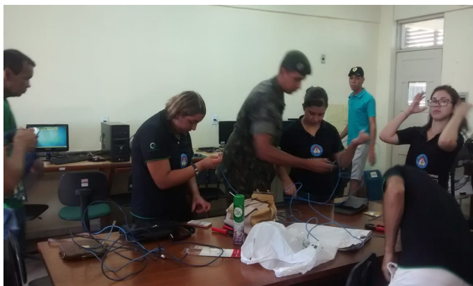
Figura 2 - Momento em que a equipe prepara patch cords para substituir os antigos daquele ambiente.
