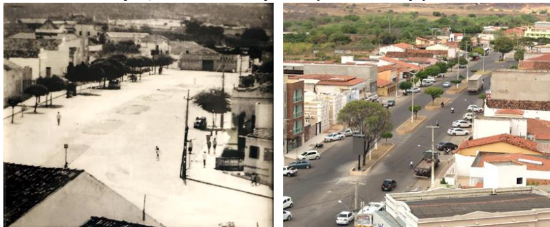
Figura 7 – Avenida Getúlio Vargas vista a partir da torre da igreja
