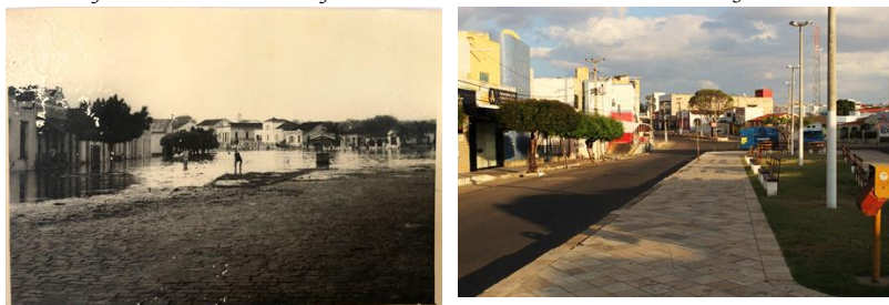
Figura 8 – Avenida Getúlio Vargas vista do seu início do entroncamento com a Rua 15 de Maio
