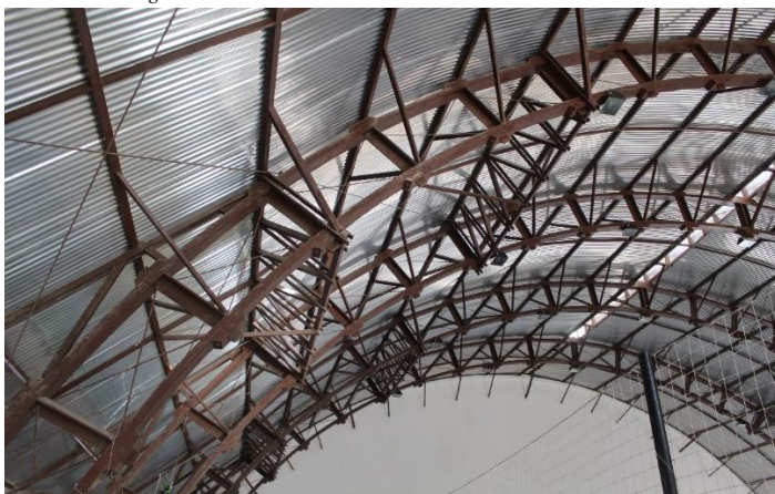
Figura 8 – Abertura do lanternim e tesouras de contraventamento
