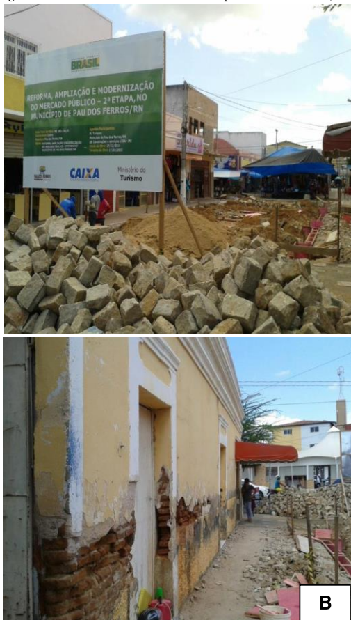
Figura 11: Início das obras do Mercado Municipal de Pau dos Ferros, 2015
