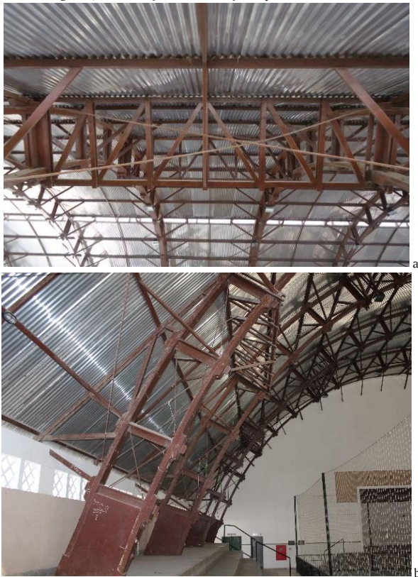
Figuras 5 e 6 – Treliças de estabilização e apoio lateral dos arcos
