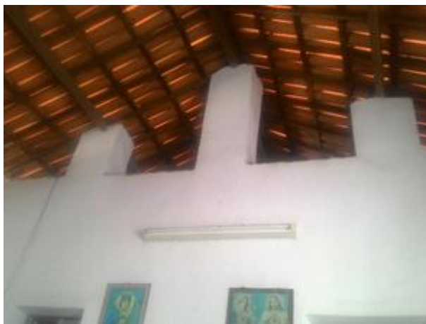
Figura 18 – Imagem do telhado na residência
