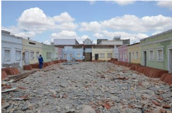
Figura 15: Mercado Público de Pau dos Ferros no período das obras de reforma, 2015
