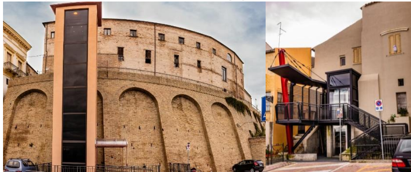
Figuras 27 e 28 – Detalhe da inserção dos elevadores que possibilitam acesso ao centro histórico
