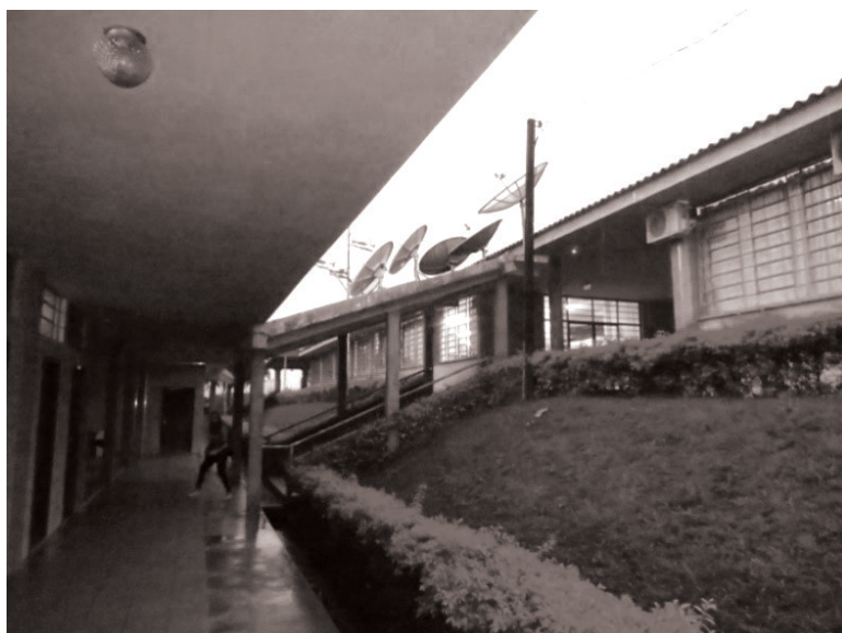
Figura 1: Vista lateral do Colégio Estadual do Reassentamento São Marcos
