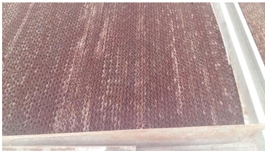
Figura 16 - Painel de celulose corrugada utilizado em sistemas de resfriamento evaporativo.
