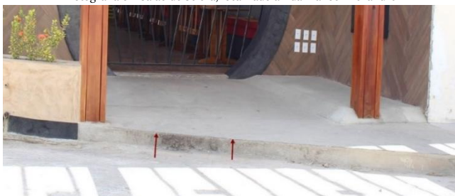
Fotografia 01: Salão de beleza, localizado à Rua Manoel Alexandre
