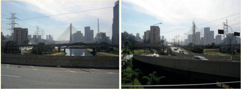
Figuras 31 e 32 – Ponte do Morumbi
